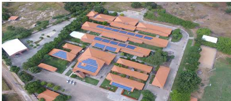
Figura 6– PLACAS SOLARES NO TELHADO DO IFPI FLORIANO
