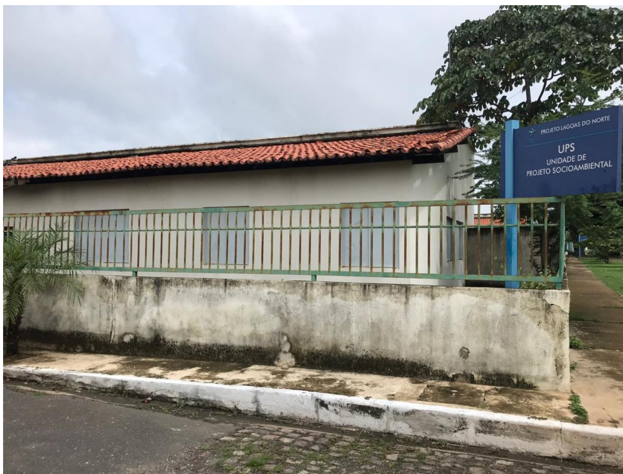
Figura 1 - UPS – Unidade de Proteção Sociambiental do Projeto Lagoas do Norte Parque Ambiental Lagoas do Norte Av. Boa Esperança - Matadouro , Zona Norte, Teresina – PI
